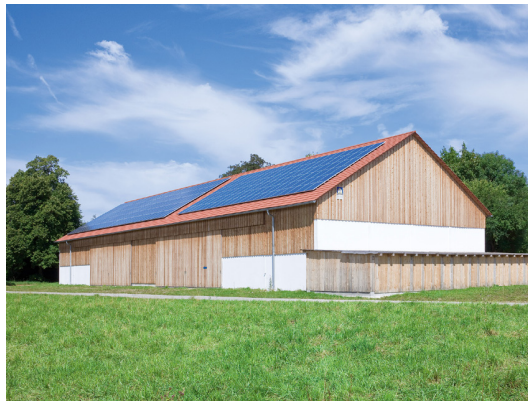
Photovoltaikanlage am Gut Großlappen
