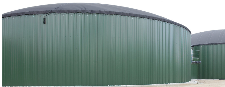
Biogasanlage am Gut Karshof
